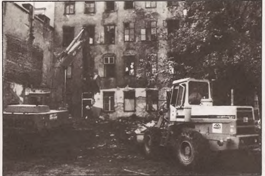
Unmittelbar nach der Räumung werden die Häuser zerstört.
